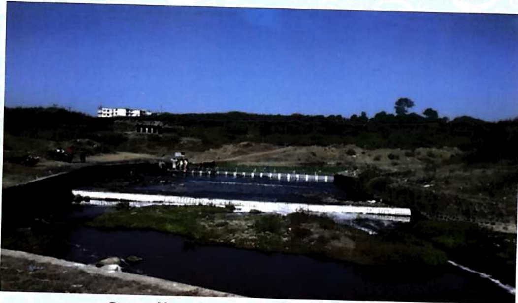
इन-सिटू बायोरेमीडियेशन डेमो प्लांट, खंदारी नाला जबलपुर
